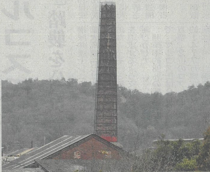
三石耐火煉瓦の煙突。明治時代から会社を支え続ける
